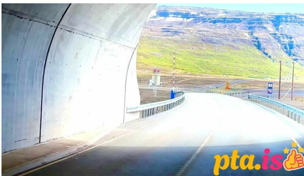
Tunnel from isafjodur to onundarfjordur myndскеid
