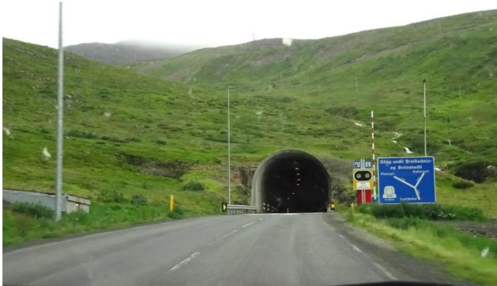
Tunnel from ísafjörður to onundarfjörður vefsiða
