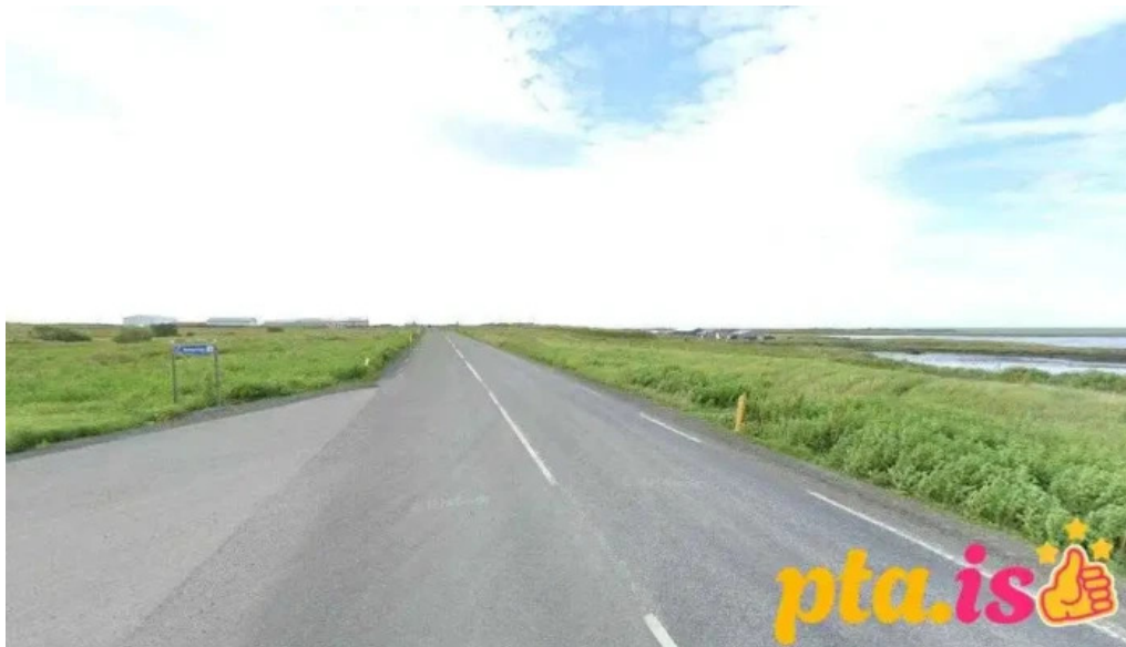
Terra umhverfisþjónusta akranes
