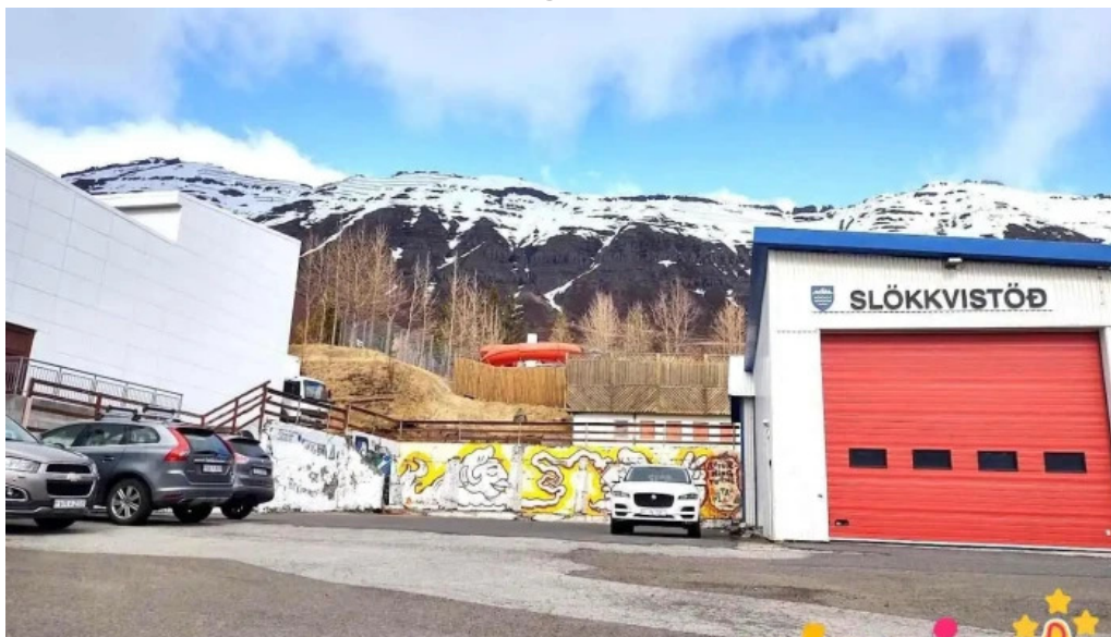
Slökkvistöð slökkviliðs fjarðabyggðar í neskaupstað neskaupstaður
