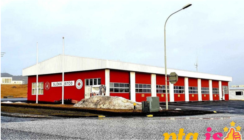
Slokkvístöð grindavík grindavík
