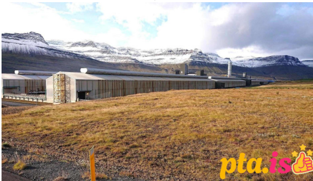
Alcoa fjarðaál fjarðabyggð
