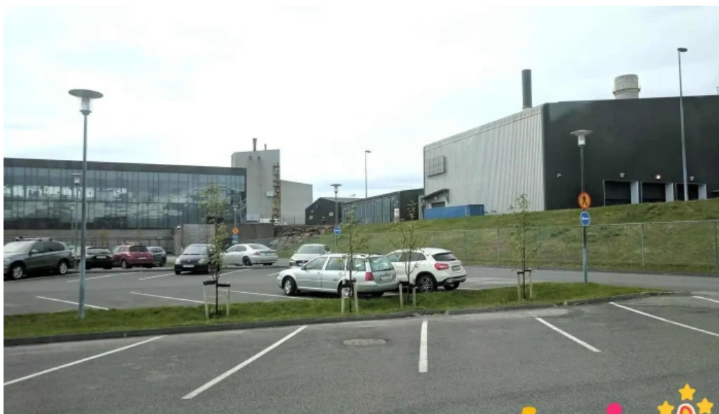
Alcoa fjardaal bygging
