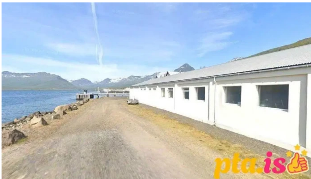
Rafmagnsverkstæði Lvf faskruðsfjörður
