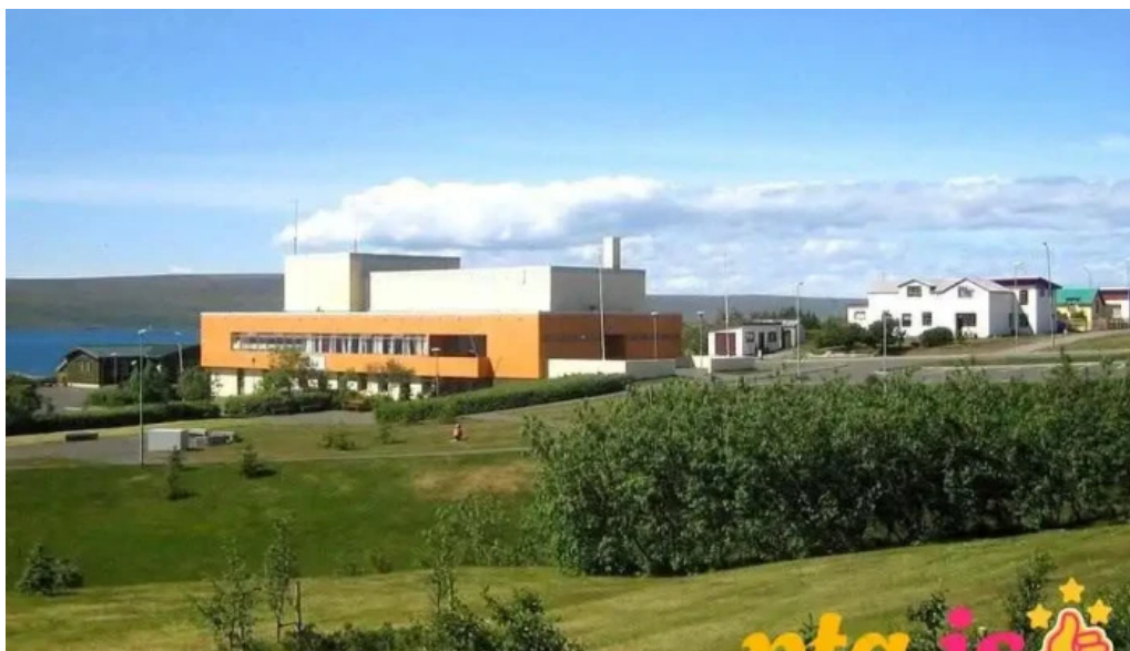
Felagsheimilið hvammstanga hvammstangi
