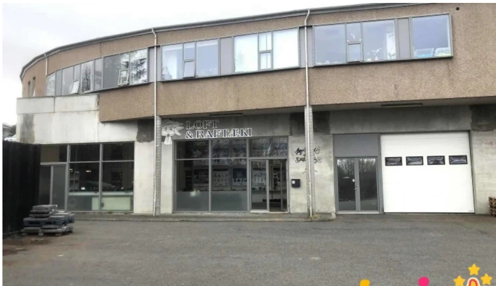
Loft og raftæki ehf bygging
