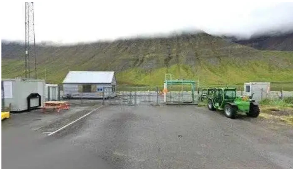
Skemmtiferdaskipahofn street view 360deg
