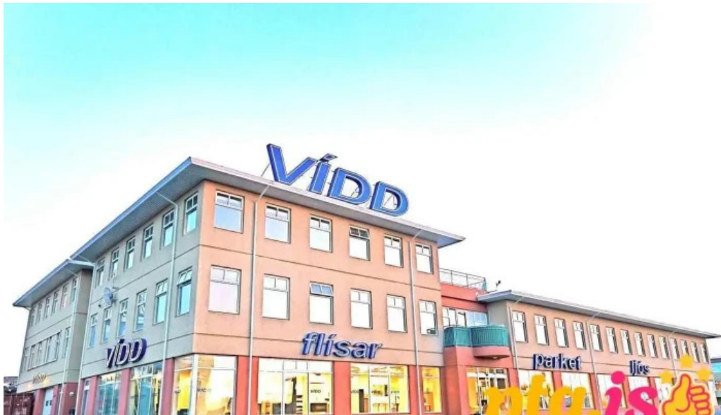
Vidd flisaverslun flisaverslun
