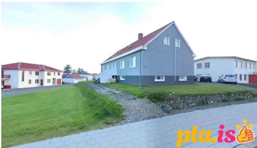
Stigvelum girðing hafnarbraut 26 780 hofn i hornafirði island hofn i hornafirði
