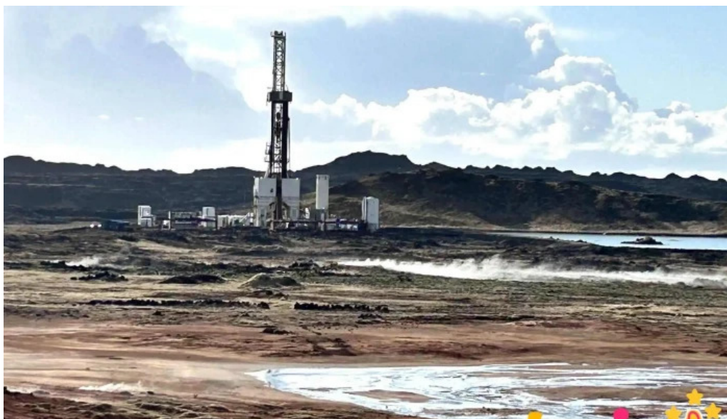
Djupborunarverkefni a reykjanesi energy supplier
