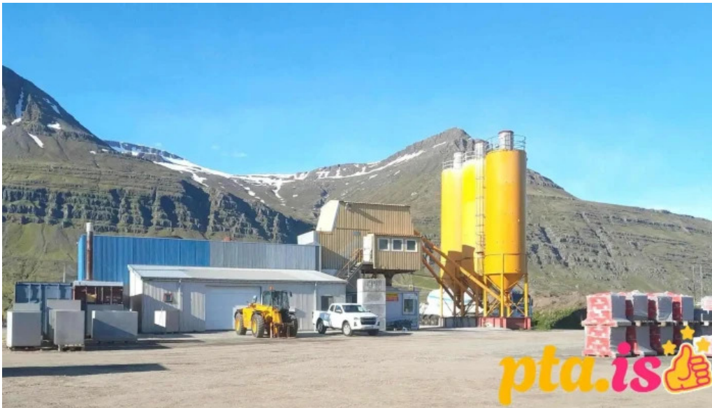
Steypustod austurlands byggingavoruverslun
