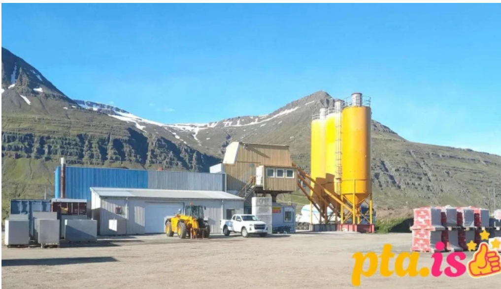
Steypustoð austurlands reyðarfjorður
